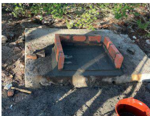
Remise en état des barbecues de la zone d'accueil © association Titè
