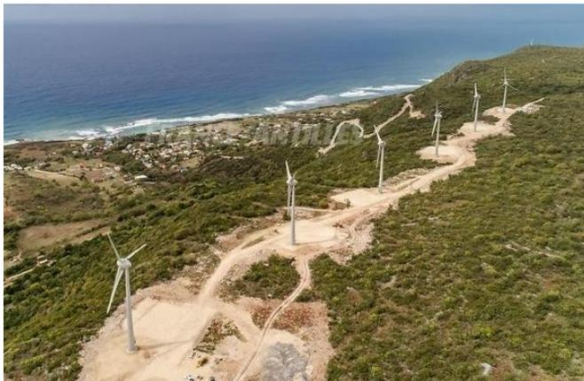
En 2019, 8 nouvelles éoliennes plus performantes ont remplacé les 35 anciennes éoliennes mises en service en 2001. Le nouveau parc éolien de la Montagne sera en capacité de tripler la production électrique qui pourra atteindre 15 GW.
