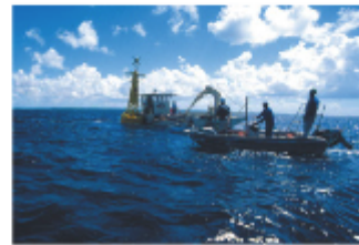
Pose d'une bouée de délimitation de la réserve
